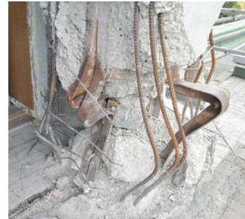
写真-2 3F 耐震壁側柱詳細
