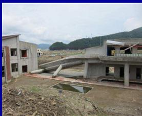
津波により片持ち柱形式の渡り廊下が倒壊
