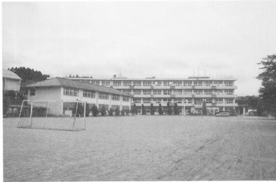
写真8 鹿島台小学校校舎の全景
