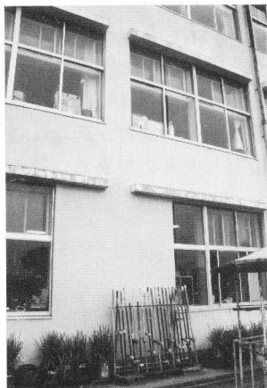
写真16 袖壁補強した柱（南構面）
