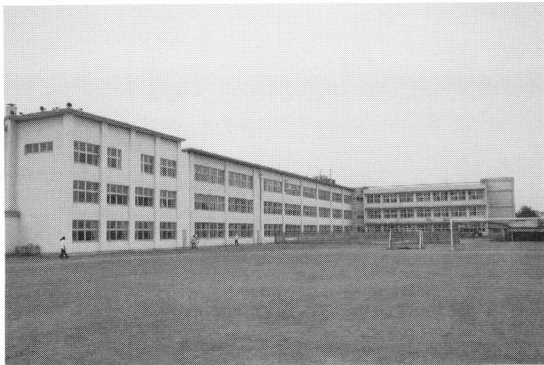
写真18 矢本第一中学校校舎の全景
