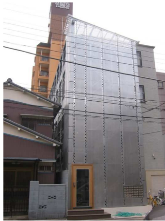
川崎区 4階建て共同住宅
