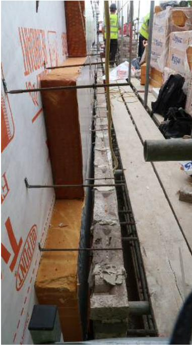
外壁 断熱材、煉瓦積み
