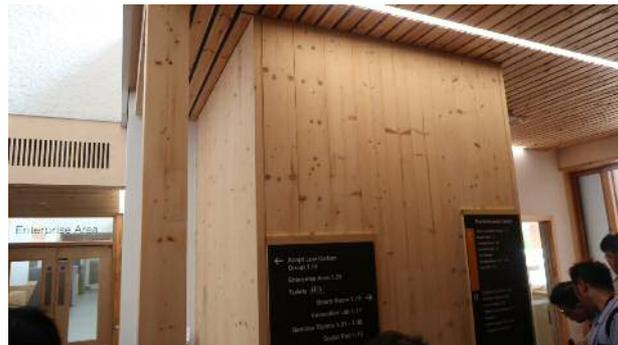
The Enterprise Center2 階吹き抜け・EVシャフト CLT
