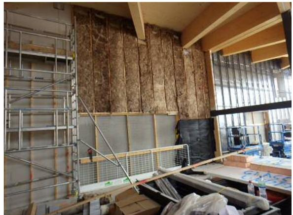
内部壁の仕上げ状況断熱材が見える
