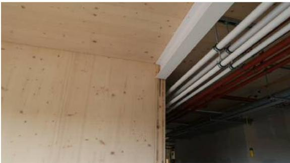
内部鉄骨フレームとCLT、ハイブリット
