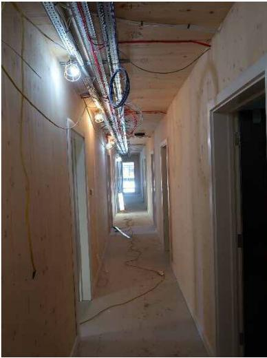
〈2階共用廊下 CLT 壁上に防火塗料〉
