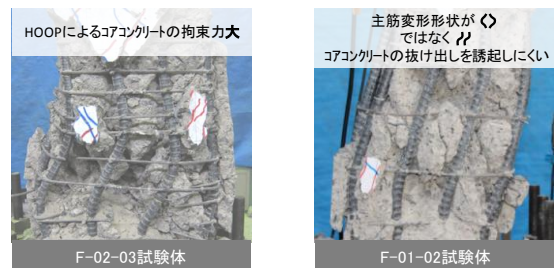
図-7 軸崩壊時の中柱の破壊性状
