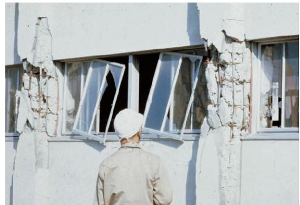
写真-3 上の写真でせん断破壊した柱のアップ
