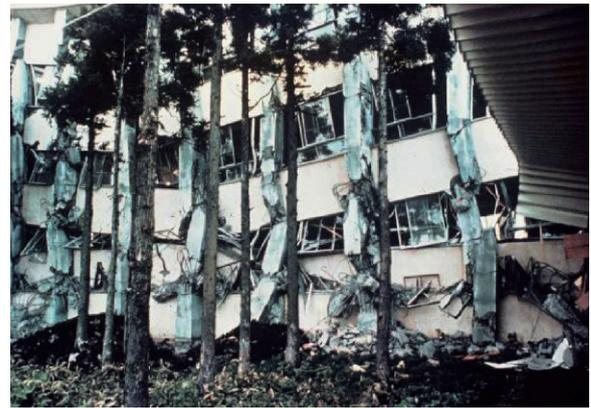
写真-1 1968年十勝沖地震で倒壊したRC造建物
