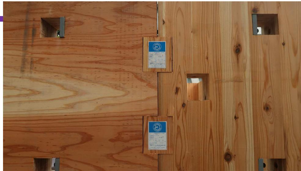
部材の凹部に集成材ダボをはめ込む新しい接合部を開発
